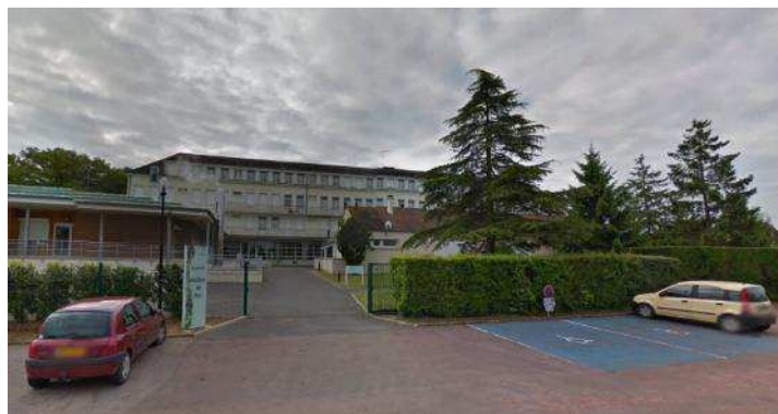
EHPAD « La résidence du Parc »
