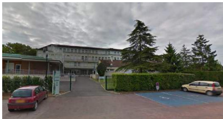
EHPAD « La résidence du Parc »
